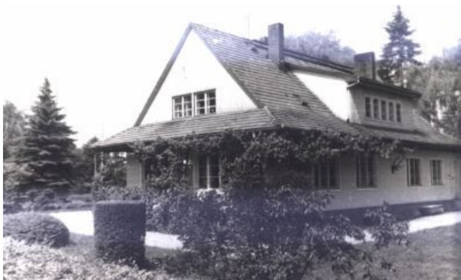
Ryc. 1. Budynek Nadleśnictwa Rychtal z siedzibą w Sadogórze
